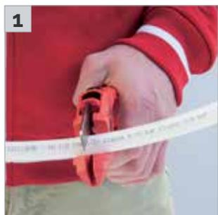
1 После того, как Вы отрезали трубу проверьте сечение на отсутствие заусенцев. Наличие заусенцев может привести к неправильному соединению.
