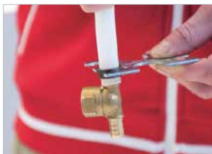
Для надежности производимого теста всегда располагайте измерительный прибор под углом 90° к фитингу.
