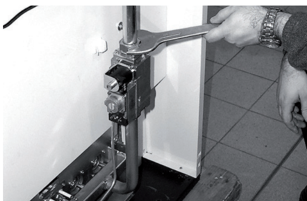
рис. 9 - Открутите гайку крепления газового клапана
