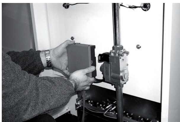
рис. 8 - Снимите блок управления
