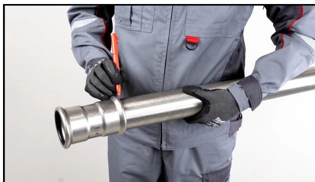
Рис. 4.2 Отметка глубины вставки d76,1-108 мм
