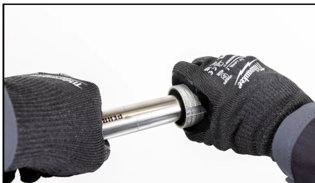
Рис. 2.1 Снятие фаски с трубы d15-54 мм
