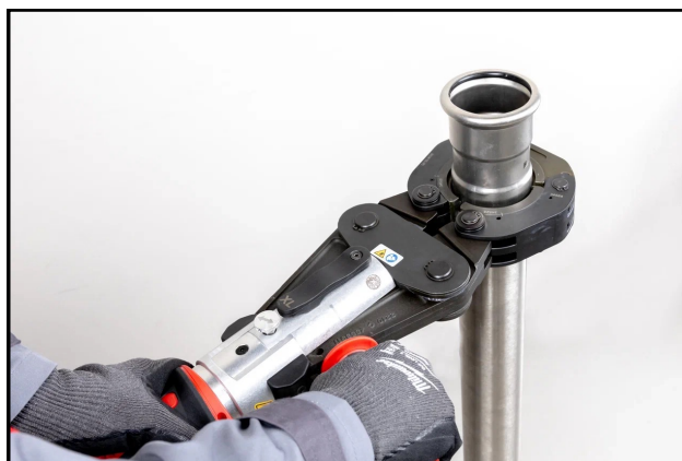
Рис. 7.4 Запрессовка (обжим) соединения
