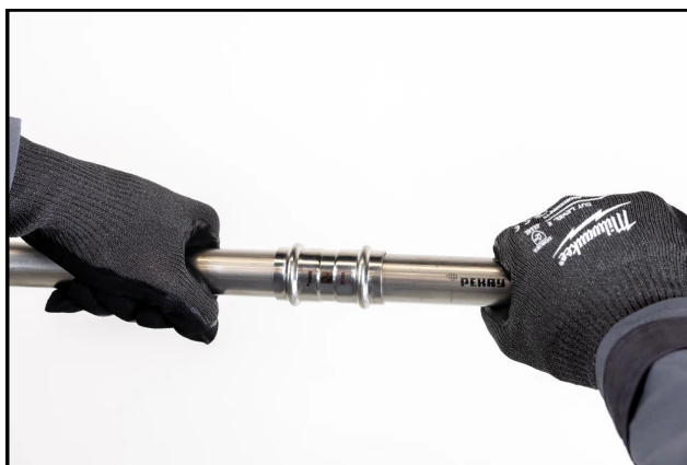
Рис. 5 Вставка трубы в пресс-фитинг
