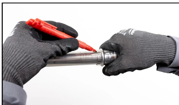
Рис. 4.1 Отметка глубины вставки d15-54 мм
