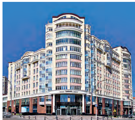
Элитный жилой комплекс «Клубный Дом Тихвинь» г. Екатеринбург
