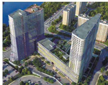
Жилой комплекс «Утесов» г. Москва
