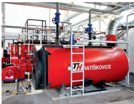
Агрофирма «Липецк», Энергоцентр Липецкая область, село Кузьминские Отвержки
