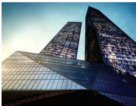
Бизнес-центр «ОКО» г. Москва
